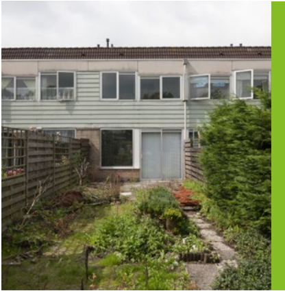
Montfoort, Nederland, vóór renovatie. Foto: Torben Eskerod.
